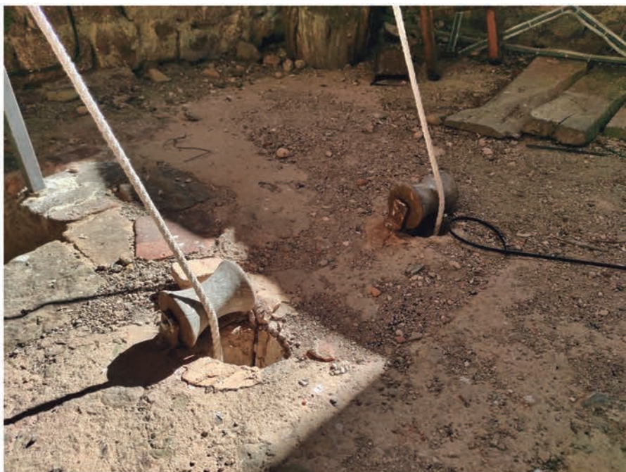
Corrons per facilitar el moviment de la corda quan el campaner toca des de la nau de l'església.
